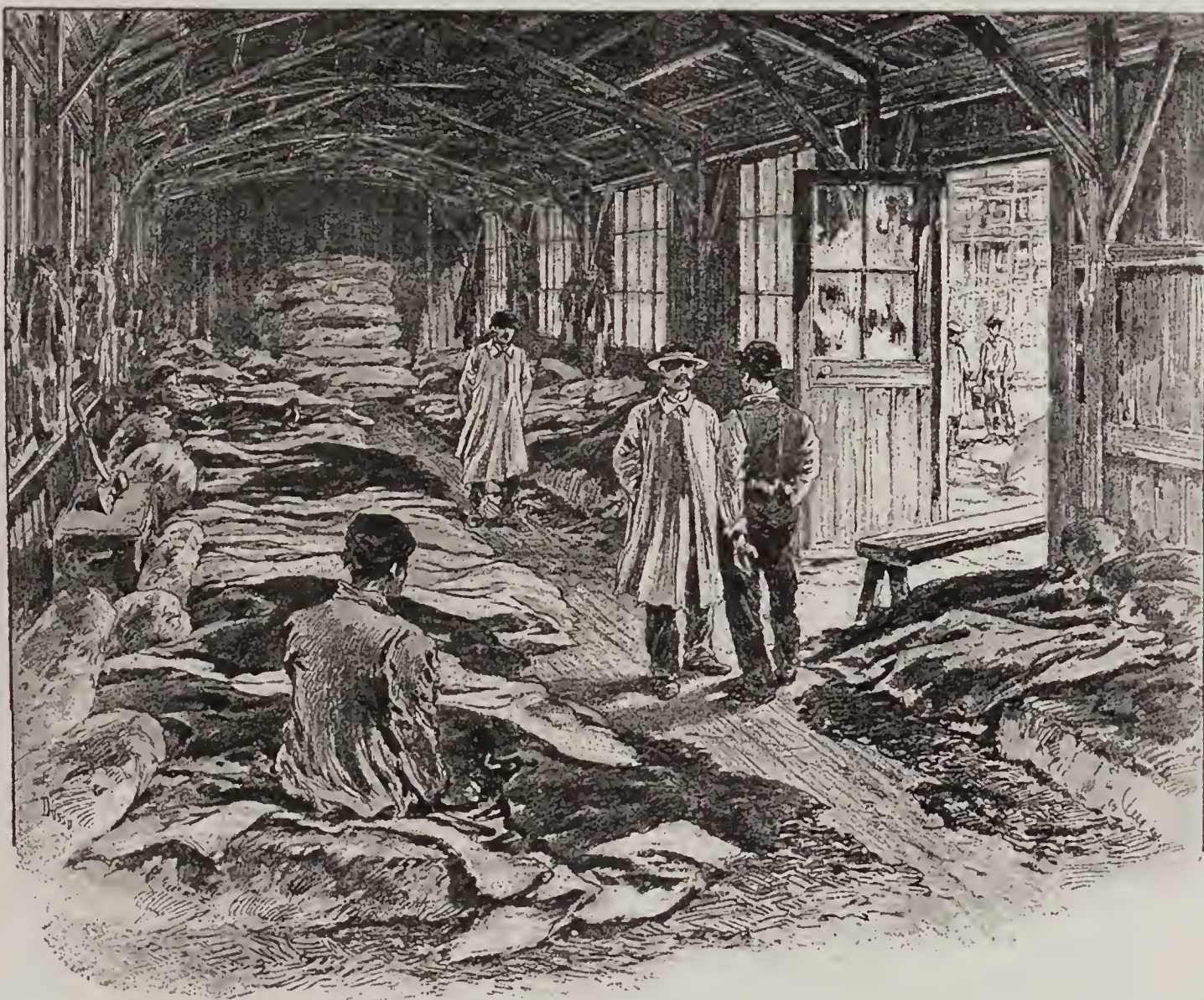
LA GRÈVE DES OUVRIERS DE L'EXPOSITION. Dortoir installé sur les chantiers des Champs-Élysées.
